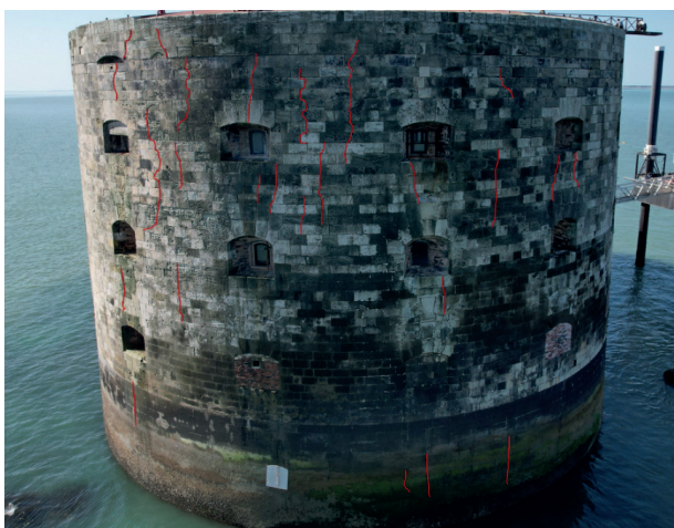
Illustration sur la fissuration extérieure sur la façade Nord-Ouest.
