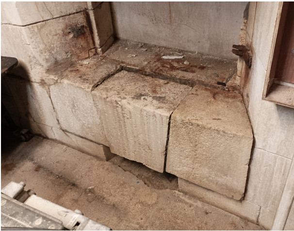
Fissure dans l'enceinte intérieure du fort.
