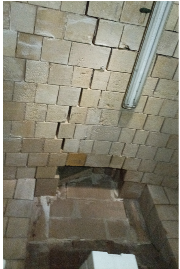
Fissure sur le plafond dans l'enceinte intérieure du fort.
